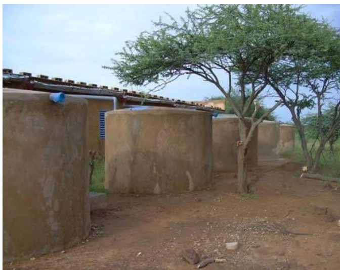
Photo 27: Système d'impluviums en ferrociment pour stocker l'eau
