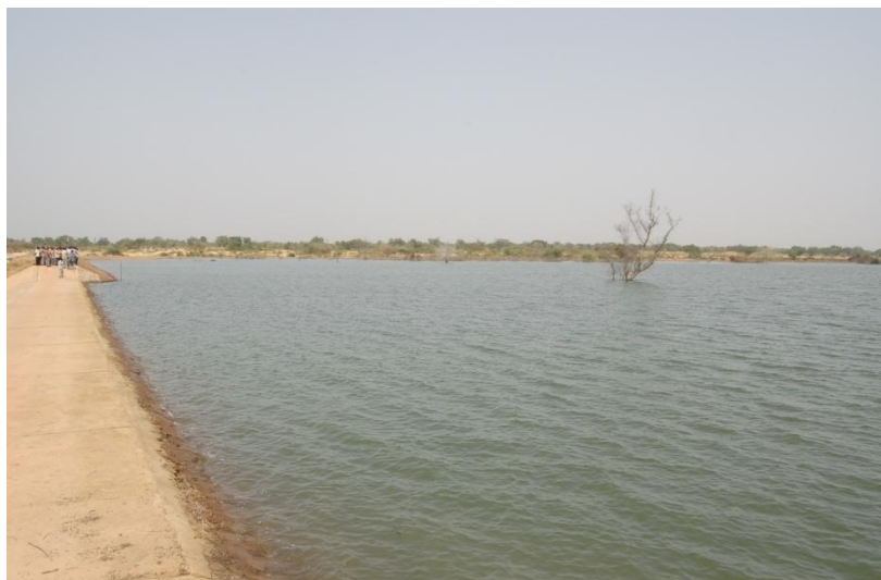
Photo 24 : Plan d'eau d'un barrage
