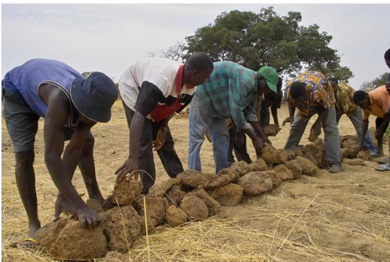
Photo 1 : Diguettes en Cordons pierreux
