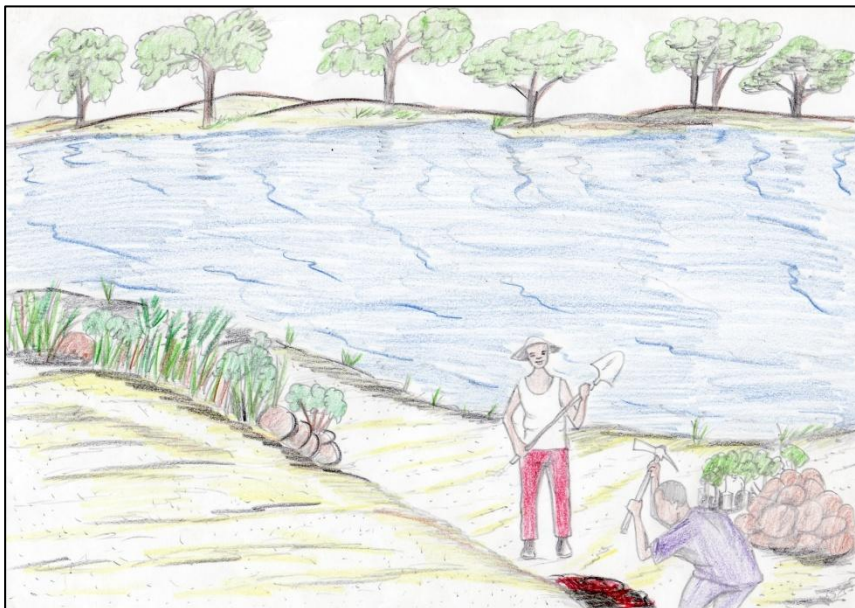
Figure 8: Protection des berges d'un cours par plantation de ligneux
