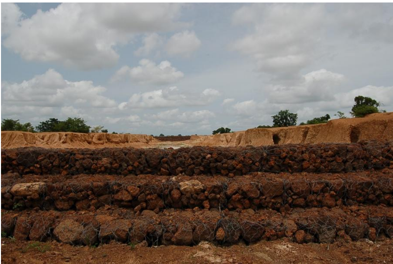
Photo 3 : Diguettes filtrantes au niveau d'une ravine
