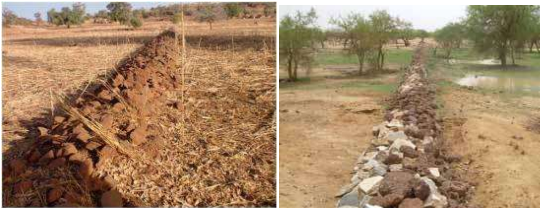
Dispositif de digue filtrante
