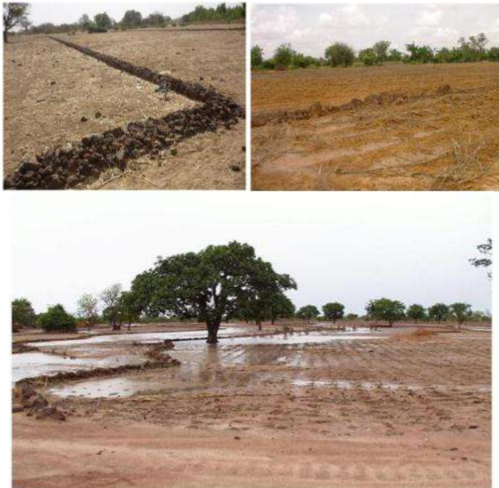
Mise en place de cordons pierreux
