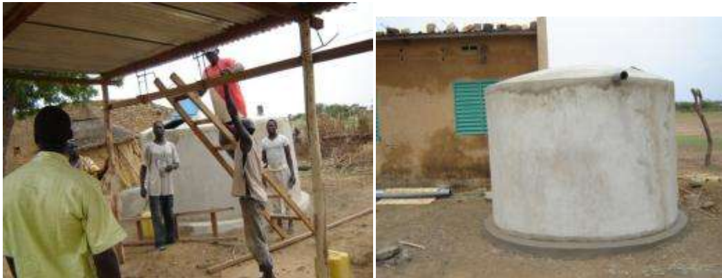
Construction d'un impluvium dans la province du Séno
