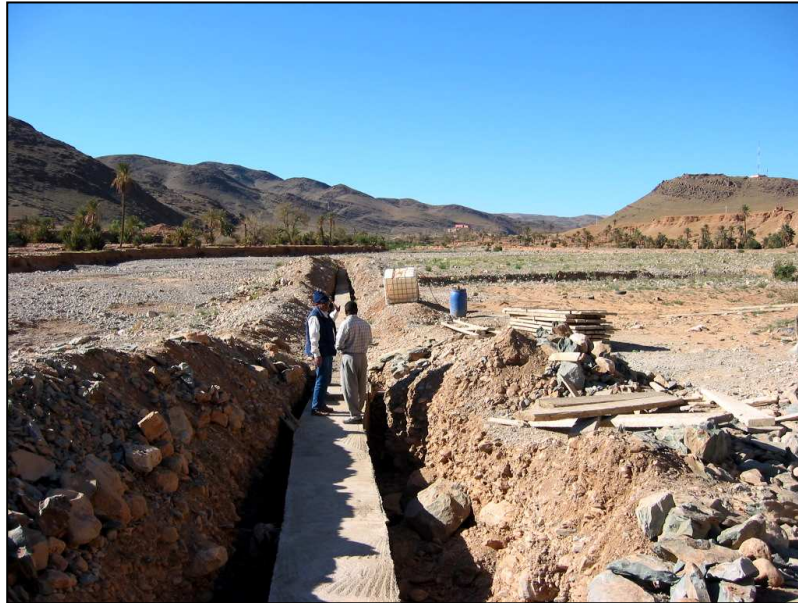
Photo 16 : Cimentation d'une galerie de khettara par la DPA. (Tagnart)
