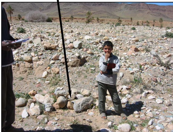
Photo 7: Puits d'aération masqué par les alluvions.
