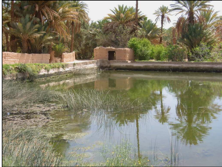
Photo 1 : Le bassin d'accumulation de la khattara d'Agadir Lehna
