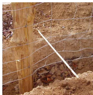
Photo 23 : piquet guidant la pose du grillage
