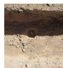
Photo 17 : marquage des centres des trous dans la tranchée
