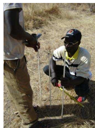
Photo 9 : piquetage de la largeur de la tranchée
