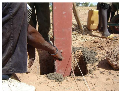
Photo 1 : alignement du poteau
