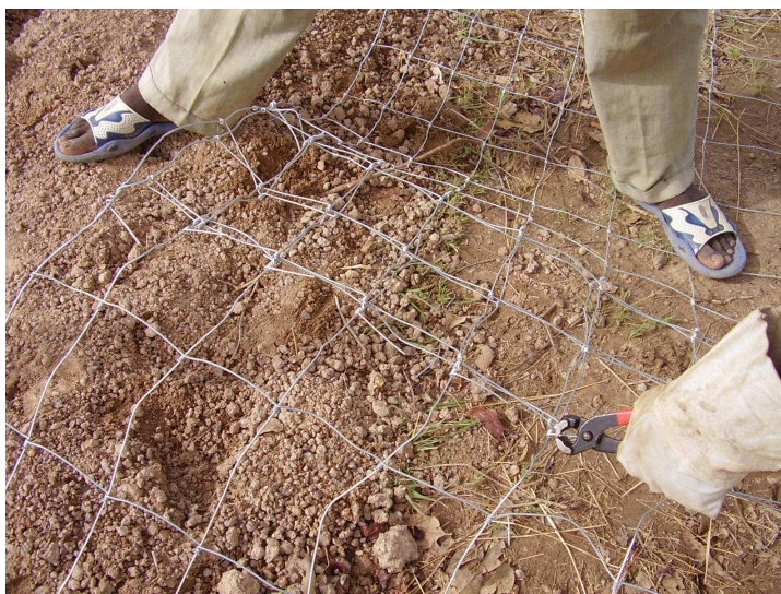
Photo 25 : réalisation d'un raccord de grillage
