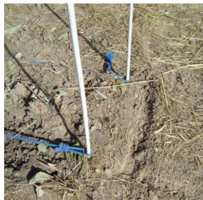
Photo 11 : marquage d'une cale
