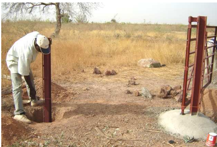
Photo 4 : pose du second poteau
