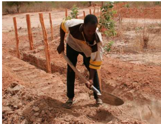
Photo 27 : rebouchage de la tranchée
