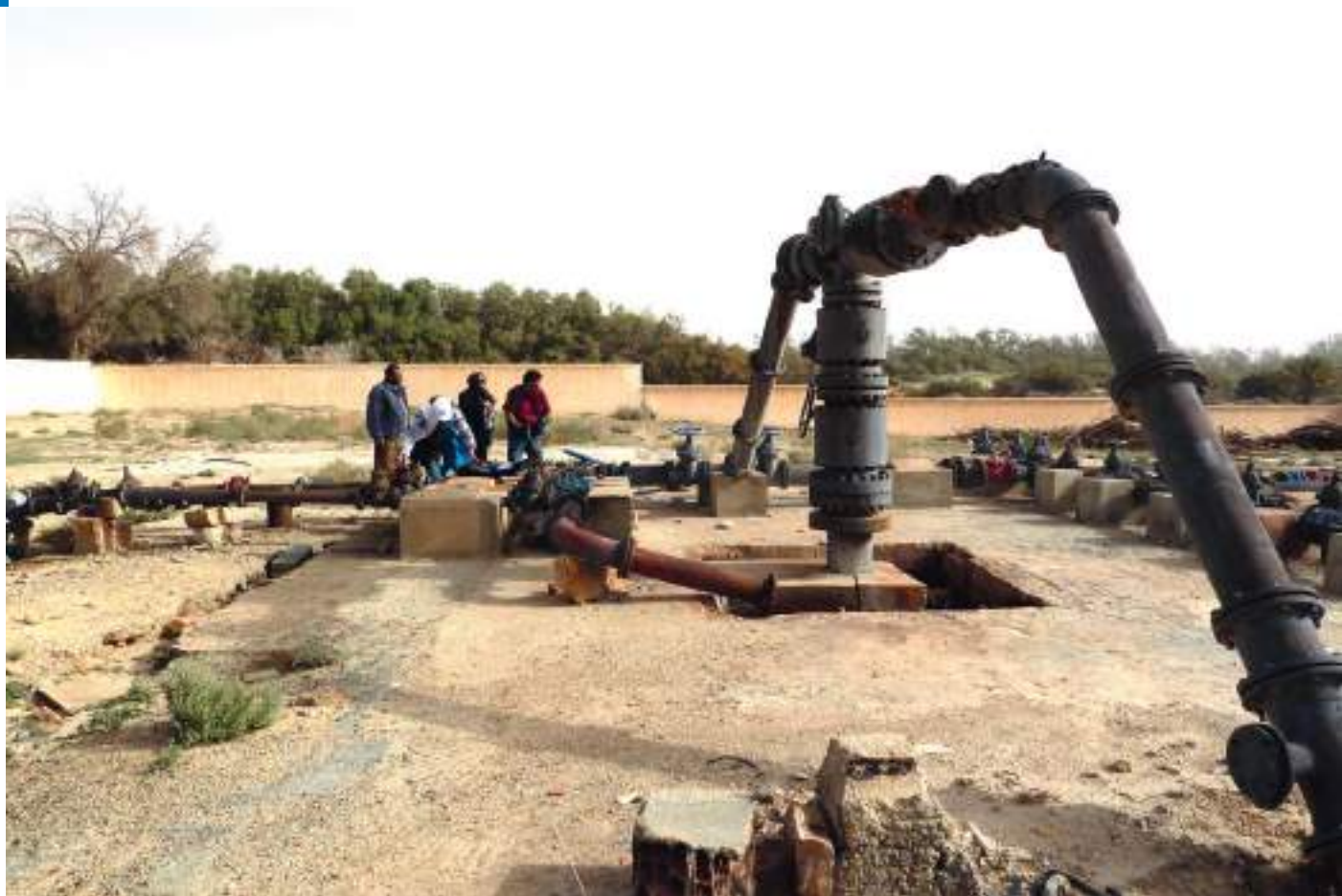
▲ Forage artésien de la ville de Douz, région de Kebili dans le sud-tunisien. Pierre Deschamps © IRD
